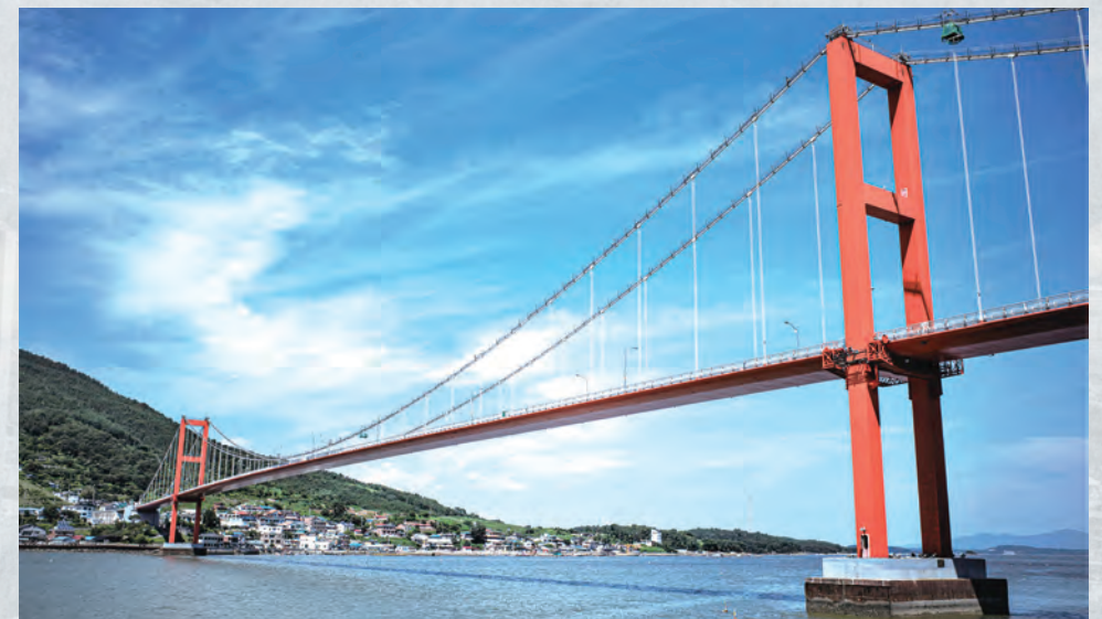
바다를 건너는 붉은 현수교, 남해대교의 위용. ©남해군청
