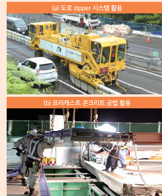
〈그림 1〉 도로 리뉴얼의 비용 절감 및 공사 기간 단축을 위한 공사 방식의 예
