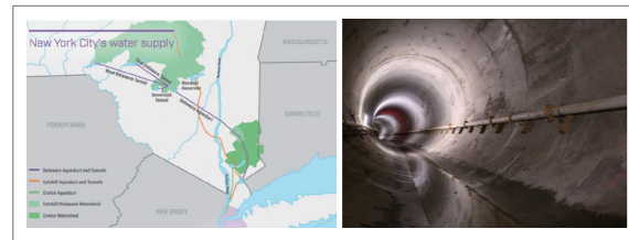
[그림 15] Delaware Aqueduct Tunnel
