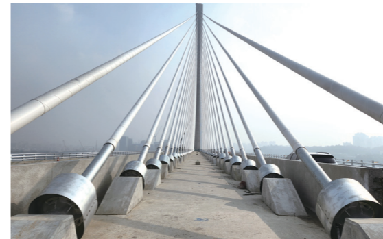
[그림 9] 마찰 댐퍼 및 이동식 케이블 설치용 작업발판
