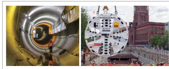
[그림 23] 베를린 U5 프로젝트에서의 터널 굴착(TBM)
