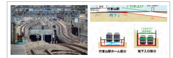
[그림 10] 철도 지하화의 기술 문제 (운행 중 지하화 공사 및 지상-지하 전환공사)
