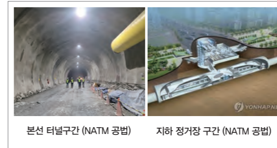
[그림 33] GTX-A 시공(본선 터널 및 터널 정거장)
