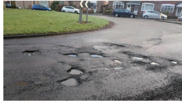
영국의 도로를 보고 있으면 이게 선진국의 도로가 맞나 싶을 정도로 열악하다. 사진은 영국의 대표적인 대도시 맨체스터의 포트를 현황.
