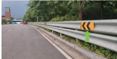
연성 방호 울타리 표지의 앞 뒤 높이를 달리하여 야간 시인성을 확보한 프리즘형 반사지
