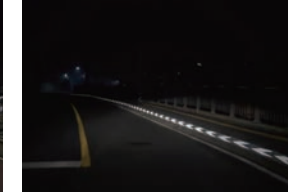
화성 종합경기타운 보차도 경계석 (가로등이 없어 전방 시인성 확보가 어려운 구간)
