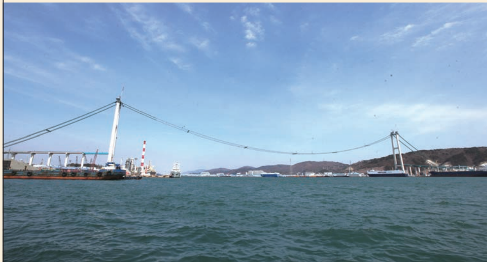
현수교에서 가장 중요한 공정에 해당하는 주 케이블 시공 모습. ©울산광역시청
